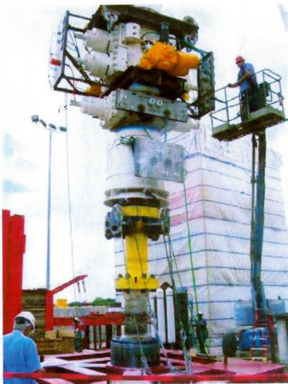
Figura 15 - Equipamento utilizado para selar o poço, Miura (2010).
