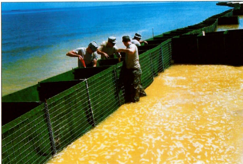
Figura 10 - Guarda Costeira, esforços para impedir que o óleo chegasse à costa. Miura (2010)
