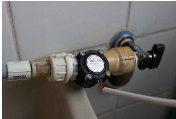
Figura 23: Instalação do medidor de vazão
