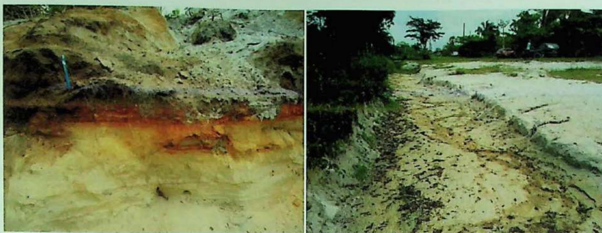
Fotos 11 e 12 – Formação Cananéia, com areia creme na base, e parte superior laterizada. Processo de erosão na lateral da linha de drenagem.
