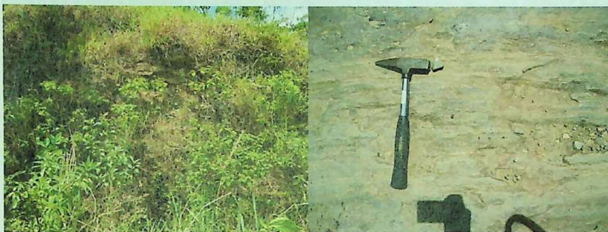
Fotos 3 e 4 – Afloramento de rocha gnáissica em corte na estrada, e detalhe da rocha no chão da estrada, detalhando a foliação gnáissica.
