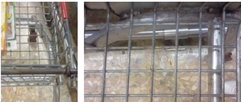
Figura 24. Superfície metálica escurecida e enferrujada. Fonte: fotos da autora.
