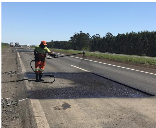
Figura 65 - Pintura realizada com caneta espargidora
