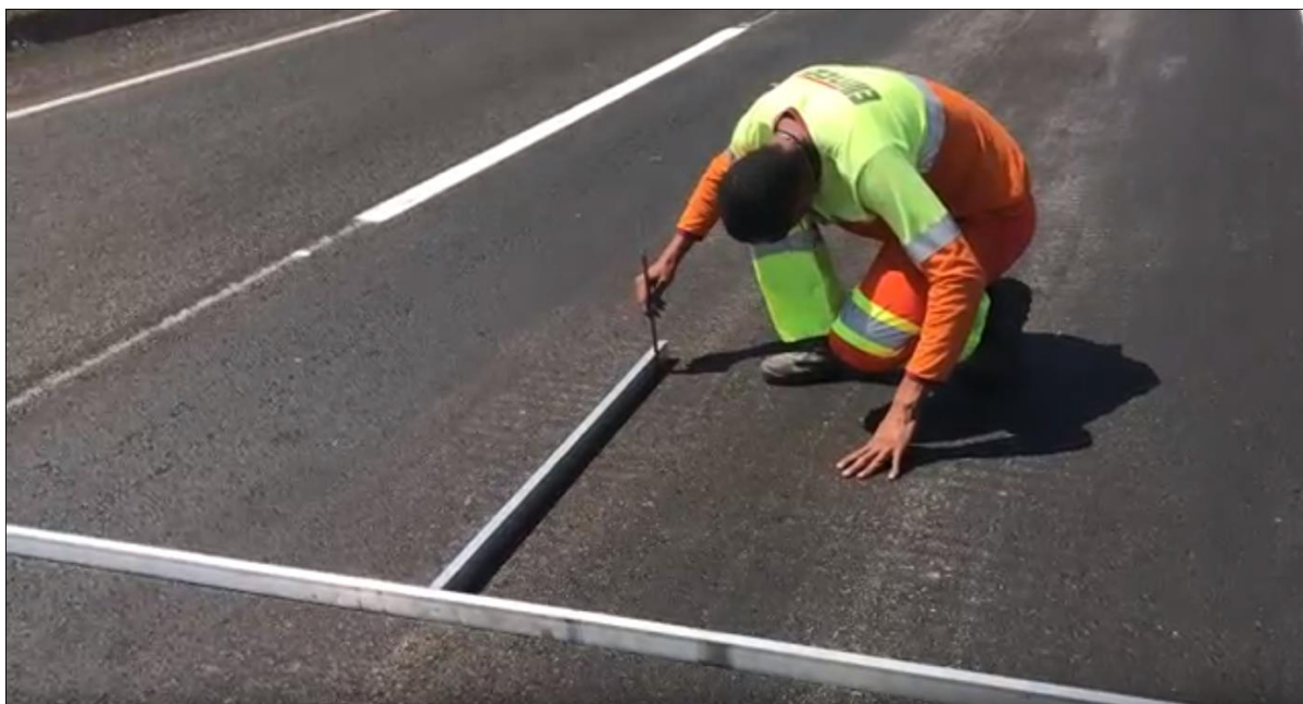
Figura 86 - Verificação do nivelamento do pavimento
