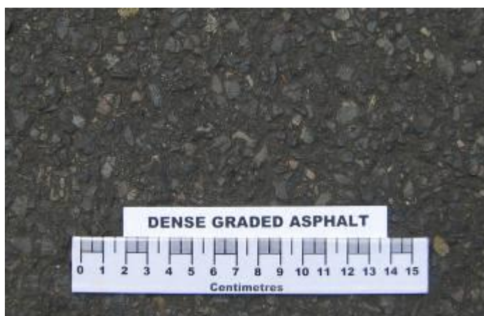
Figura 14 - Concreto Asfáltico Usinado a Quente
