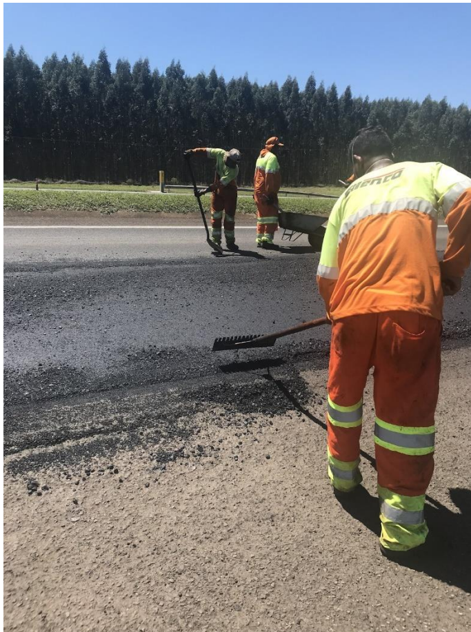
Figura 70 - Assentamento do material no perímetro
