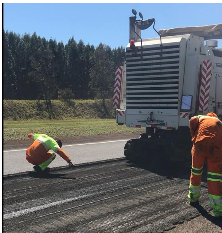
Figura 57 - Controle da espessura fresada com uso de barbante e trena
