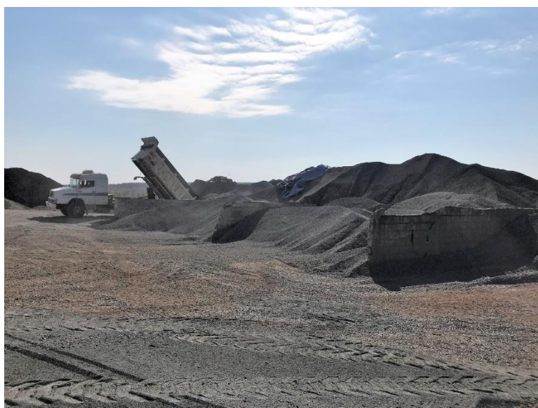
Figura 30 - Estocagem dos agregados na usina móvel
