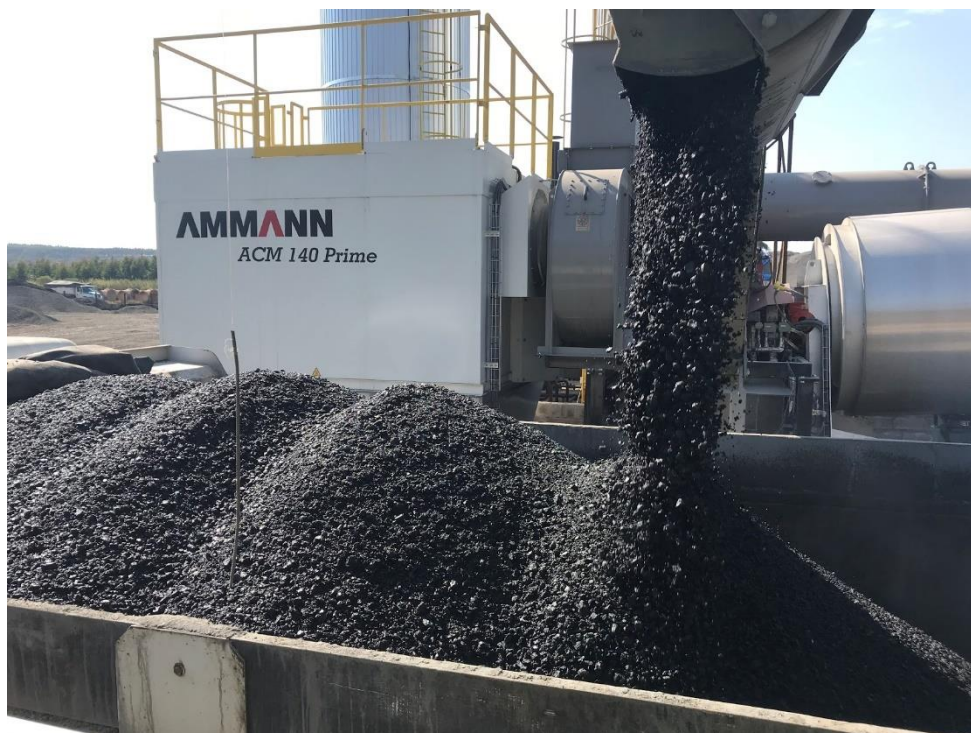
Figura 34 - Massa asfáltica sendo despejada no caminhão para transporte
