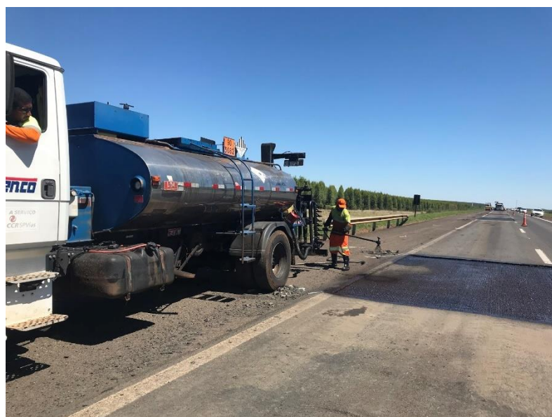
Figura 103 - Aplicação de imprimação betuminosa ligante
