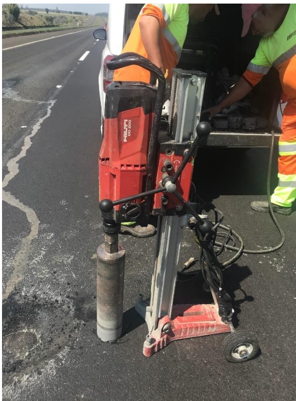
Figura 108 - Coleta de amostra para verificação de Grau de Compactação
