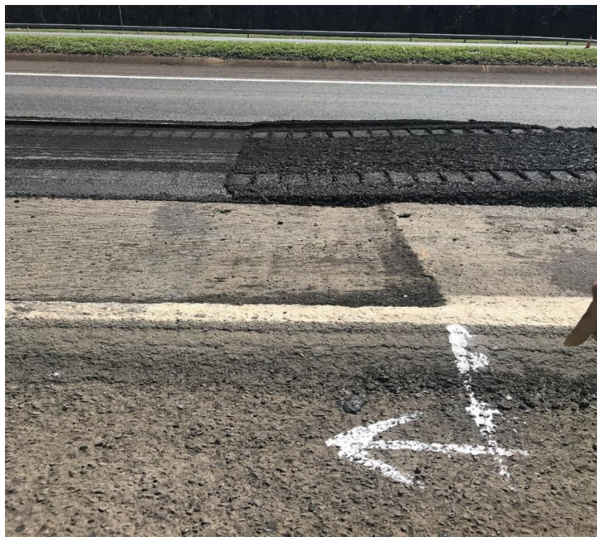
Figura 56 - Fresagem de trecho, com largura superior a oferecida pela fresadeira (2 passadas)
