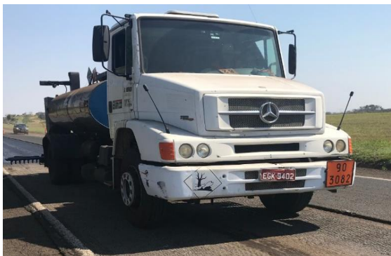
Figura 64 - Caminhão tanque com barra espargidora
