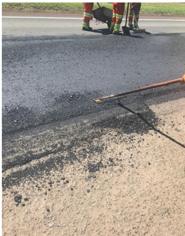
Figura 107 - Espalhamento do material asfáltico
