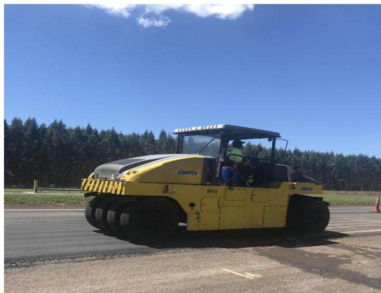
Figura 73 - Compactação: compactador de pneus
