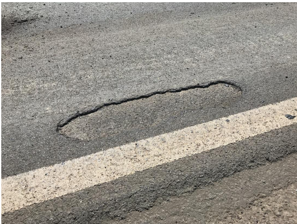
Figura 51 - Exemplo de deformação que resulta em uma NP
