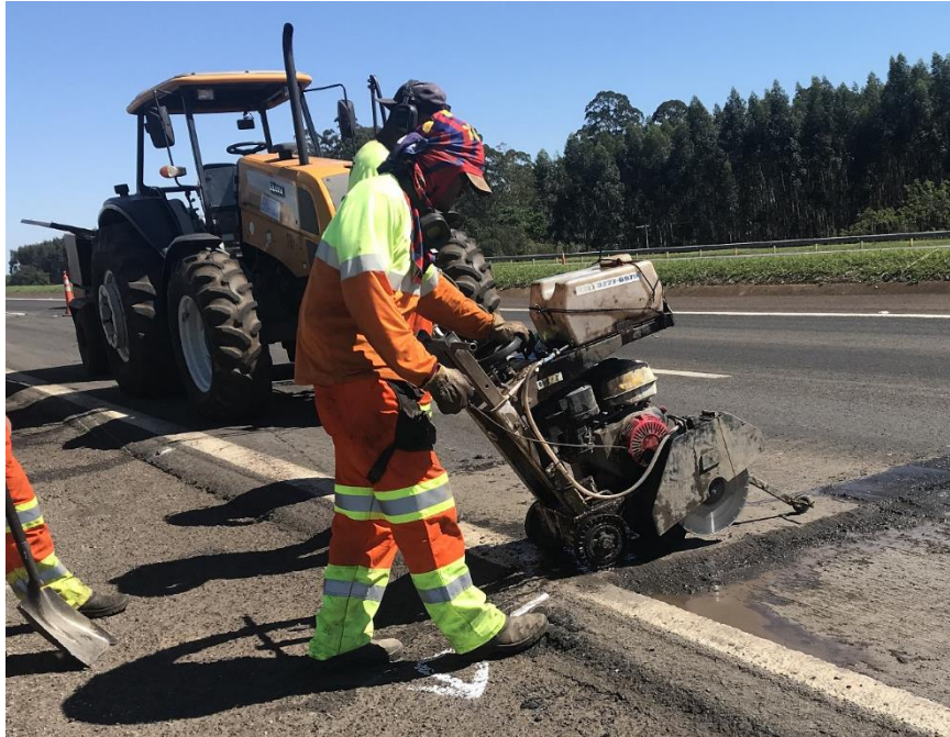
Figura 36 - Equipamento para acerto de bordas: cortadora mecânica
