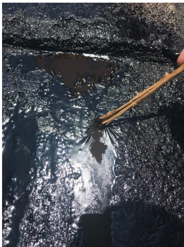
Figura 105 - Pintura de ligação acumulada nas bordas no momento de aplicação de CAUQ
