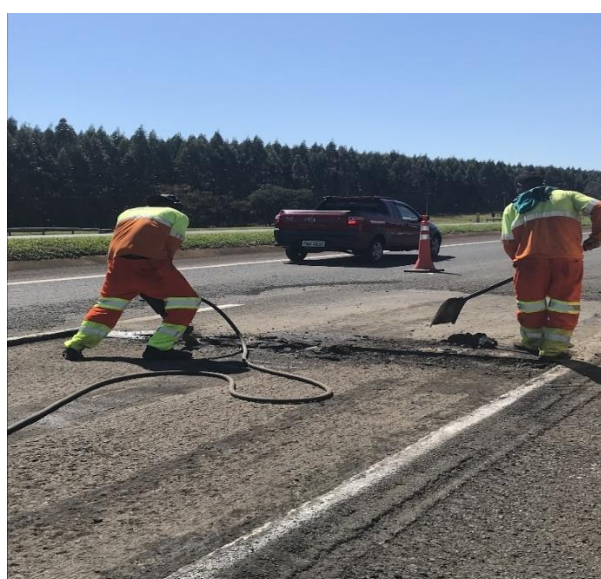
Figura 61 - Retirada do excesso cortado
