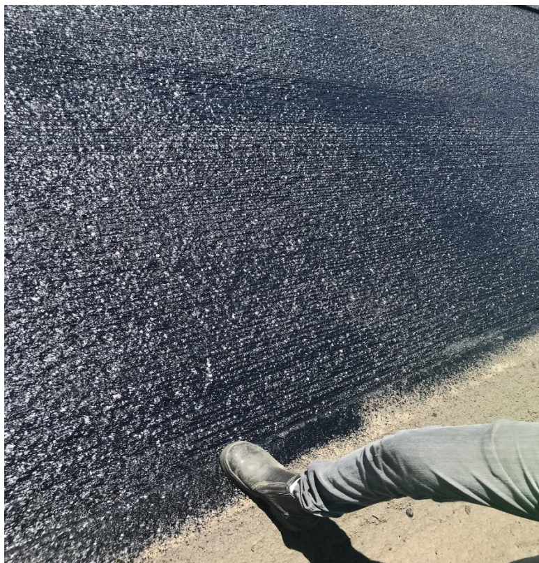
Figura 67 - Pintura de ligação após rompimento (tonalidade preta brilhante)
