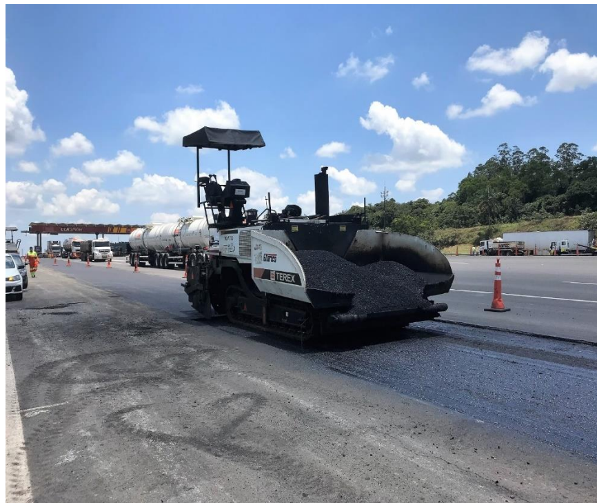
Figura 41 - Equipamento para aplicação da massa asfáltica
