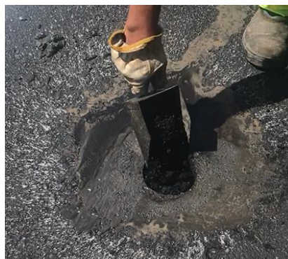
Figura 98 - Preenchimento com massa fria
