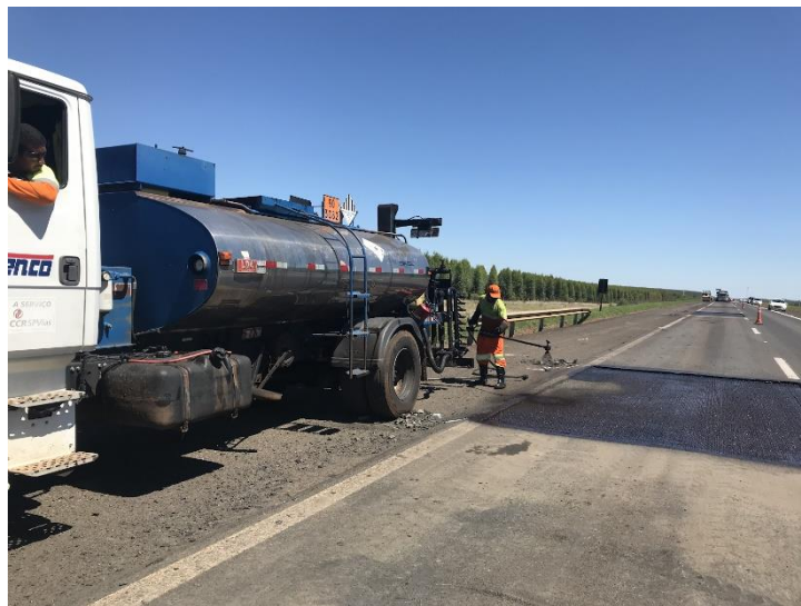
Figura 22 - Equipamento utilizado para aplicar a pintura: bico de distribuição
