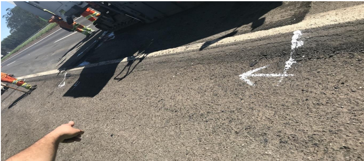
Figura 49 - Serviços preliminares: Determinação de trechos pelo fiscal da CCR
