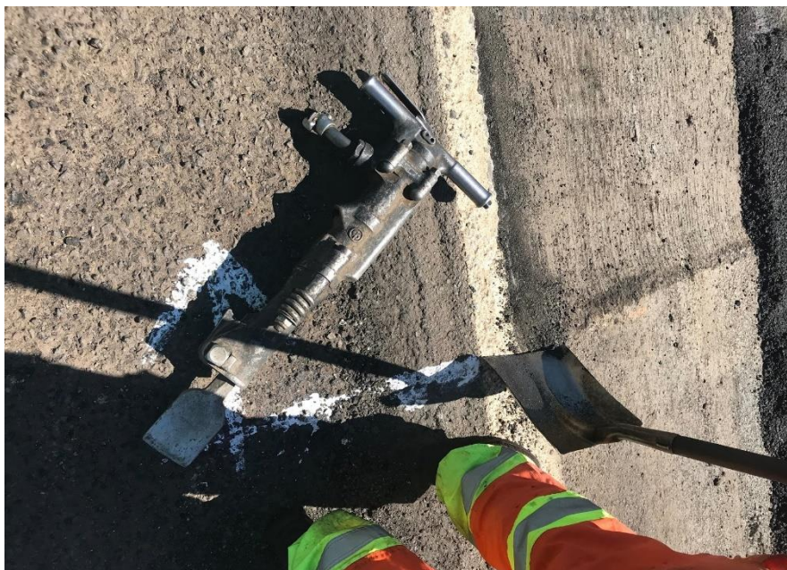
Figura 37 - Equipamento para acerto de bordas: britadeira e pá
