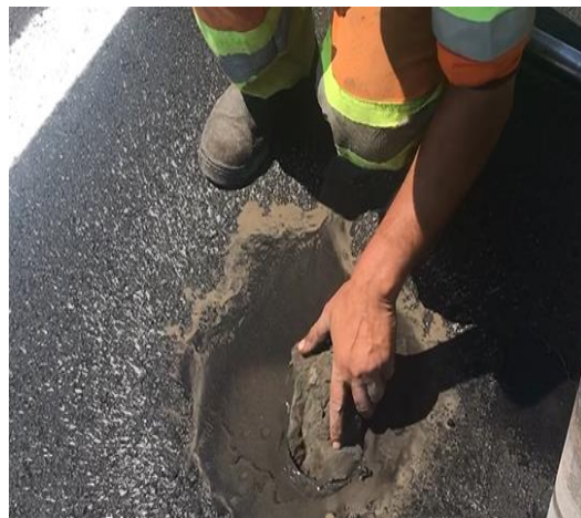
Figura 97 - Secagem do buraco com um pano
