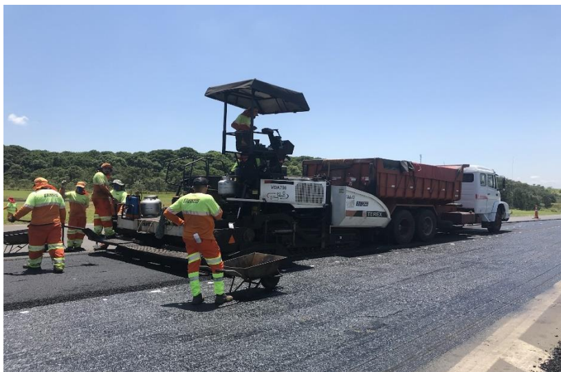
Figura 69 - Material sendo depositado no trecho
