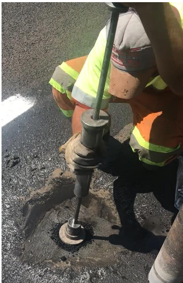
Figura 99 - Compactação manual
