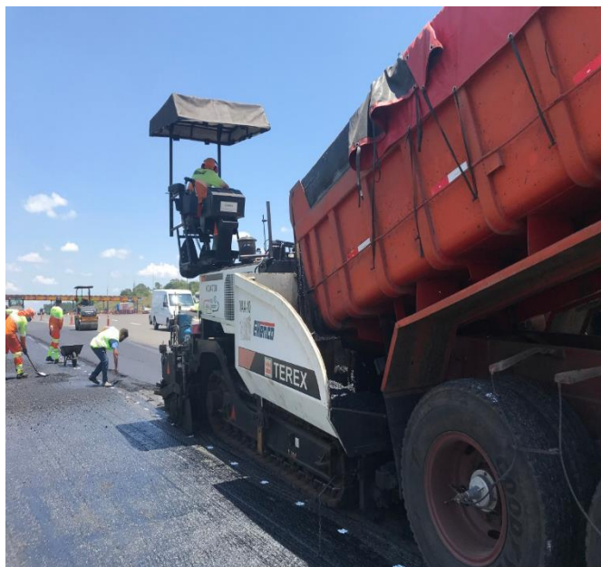
Figura 68 - Carregamento da vibro acabadora pelo caminhão basculante vindo da usina
