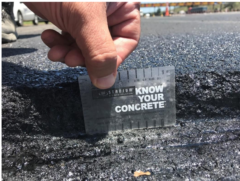
Figura 102 - Medição de profundidade de fresagem e recomposição
