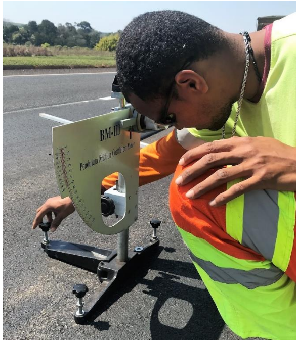
Figura 87 - Verificação de atrito: Nivelamento do equipamento
