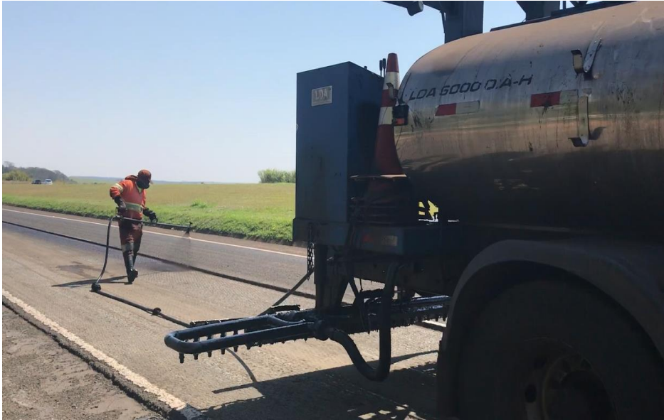
Figura 40 - Equipamentos de aplicação de pintura de ligação
