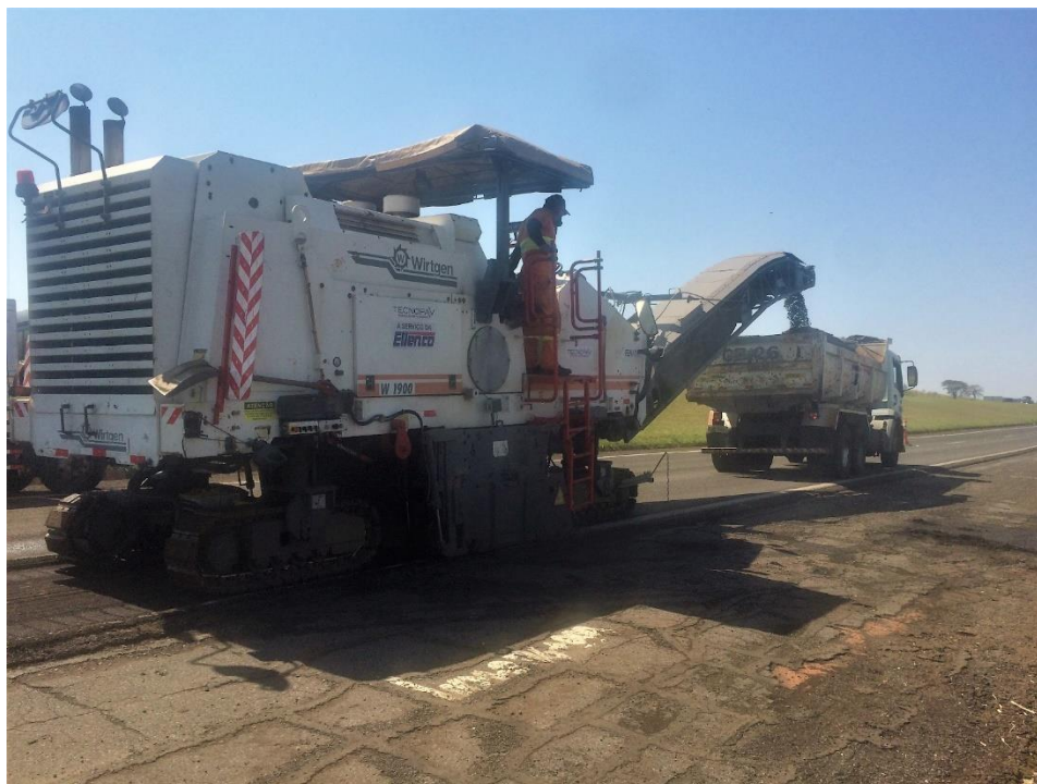
Figura 58 - Fresadeira durante serviço e caminhão basculante para coletar material fresado
