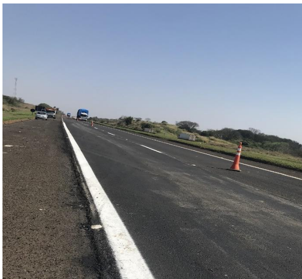
Figura 48 - Serviço preliminar: isolamento da pista
