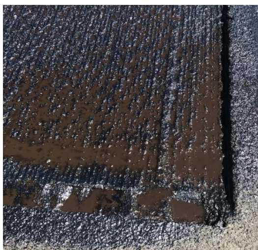
Figura 66 - Pintura de ligação não rompida (tonalidade marrom)
