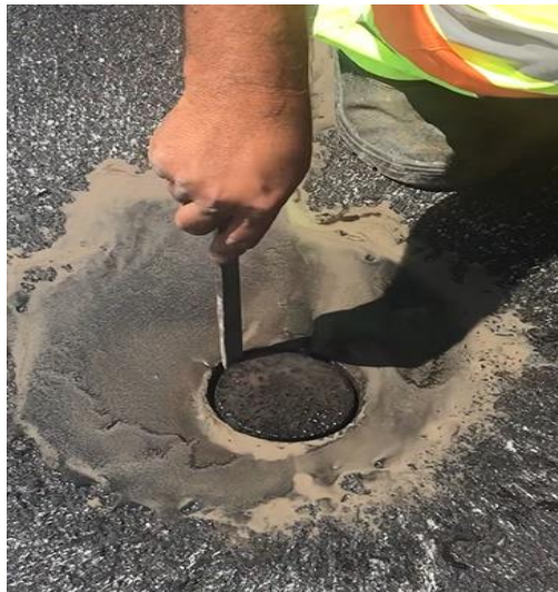
Figura 95 - Retirada do corpo já solto
