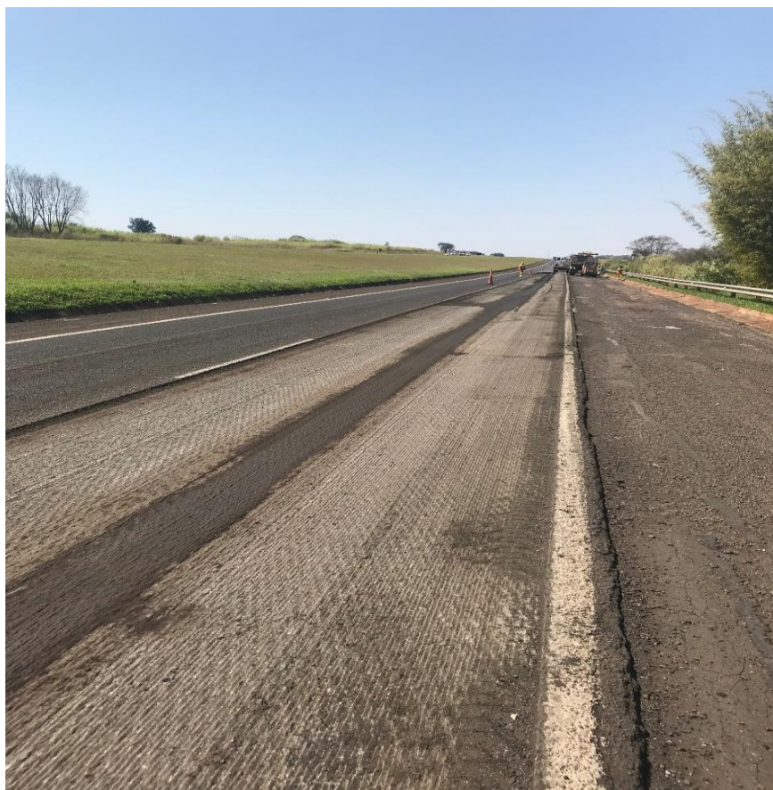
Figura 59 - Pavimento fresado em 5 cm
