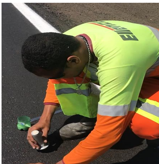
Figura 91 - Depósito da areia com volume padronizado
