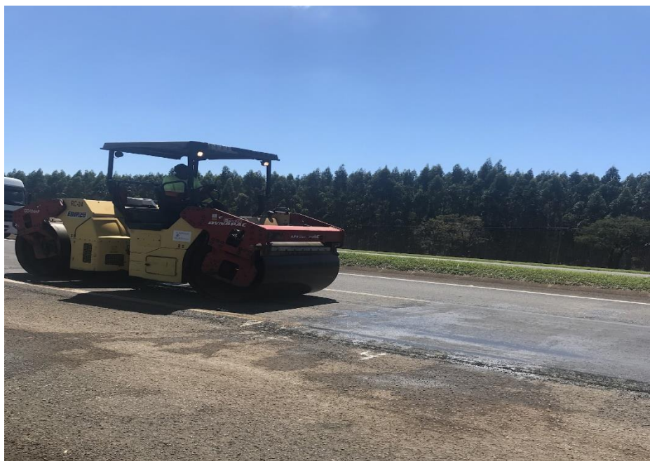
Figura 72 - Compactação: compactador de rolo liso
