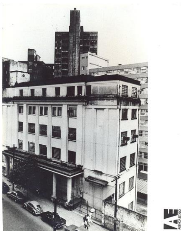
Figura 8 - Edifício Rui Barbosa, ocupado com a FFCL (década de 1960).
