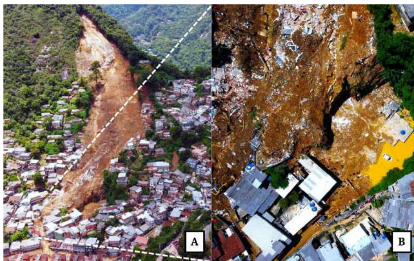
Figura 2 – (A) Deslizamento de terra no Morro da oficina após chuvas intensas em Petrópolis-RJ 2022, (B) Destruição causada pelo desastre. Fonte: REUTERS (2022).
