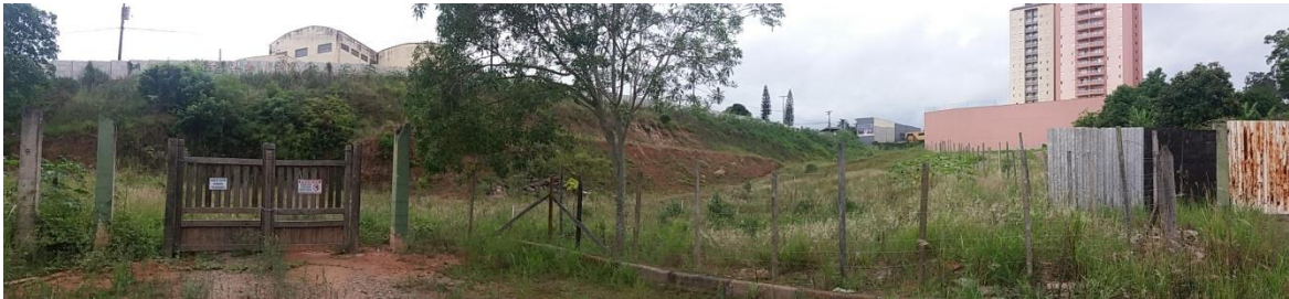
Foto 1 _ Mapa do Terreno – topografia: Vista para talude da Rua Antônio Busca.
