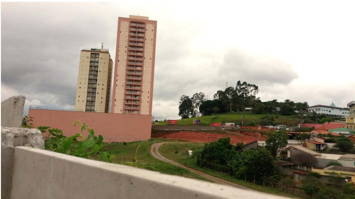
Foto 3 _ Mapa do Terreno – topografia: Vista da Rua Antônio Busca para o interior do terreno.
