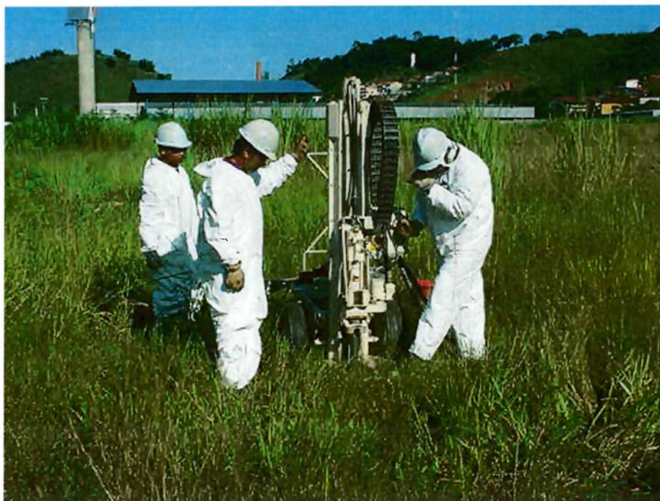
Foto 5: Equipe realizando perfuração com sistema Direct push
