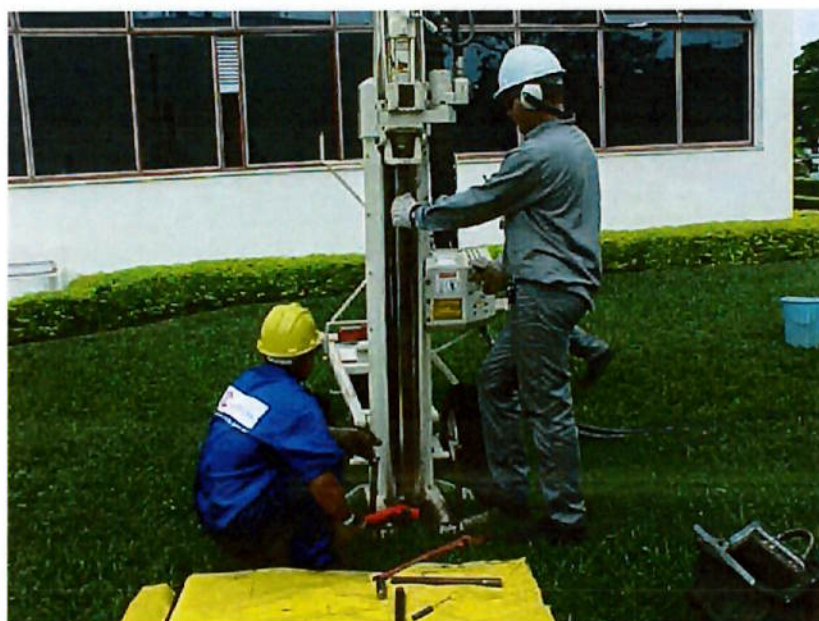
Foto 7: Equipe realizando perfuração com sistema Direct push
