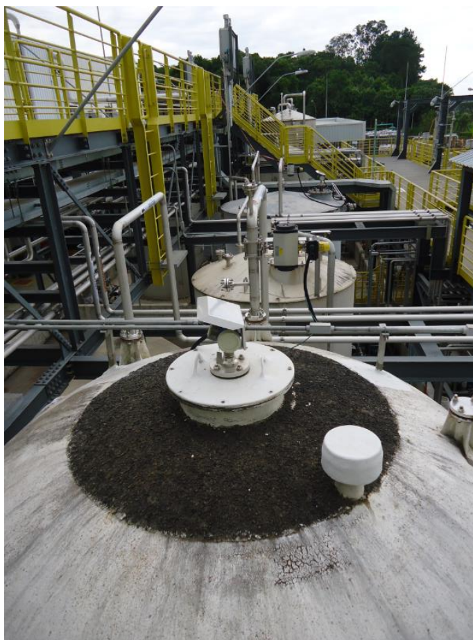
Figura 9 – Foto dos tanques inspecionados
