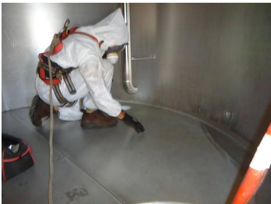
Figura 19 - Interior do Tanque de Ácido Fosfórico.
