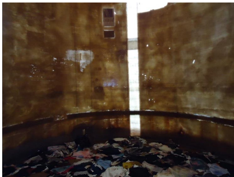
Figura 11 - Parte interna do tanque de XB antes da entrada.
