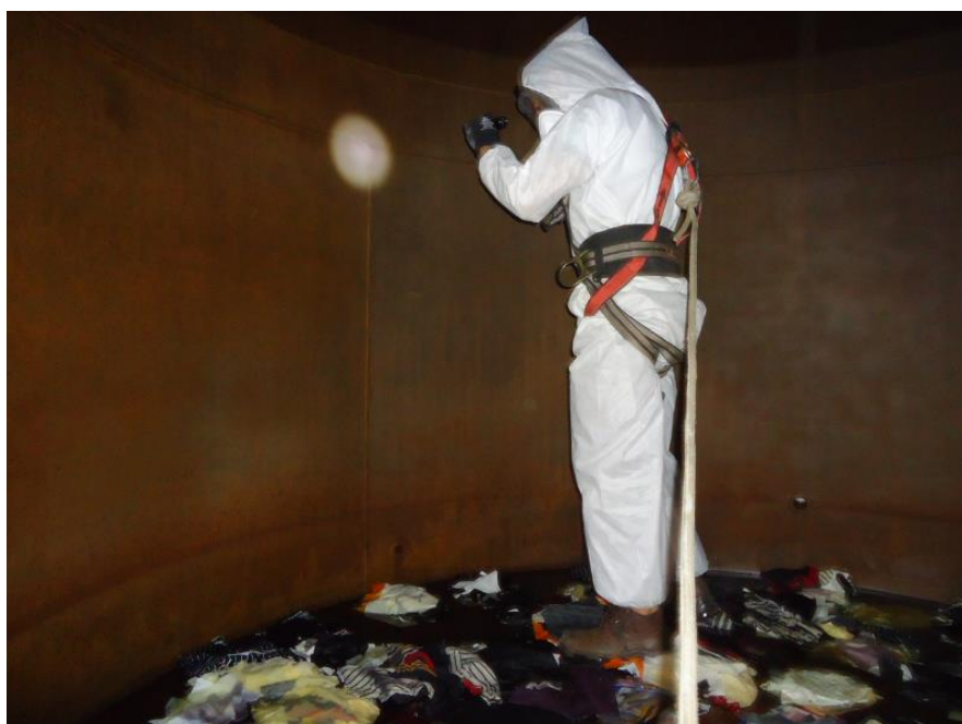
Figura 25 - Atividade no interior do Tanque de Óleo de Soja.
