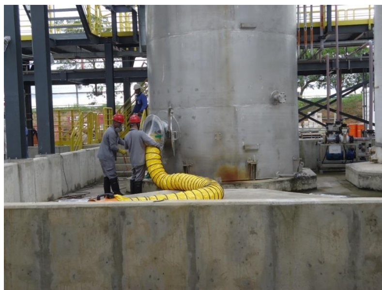
Figura 27- Colocação do equipamento de insuflamento de ar no Tanque de Ácido Fórmico.
