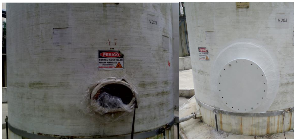
Figura 16 - Antes e Depois da Boca de Visita do Tanque de XB.
