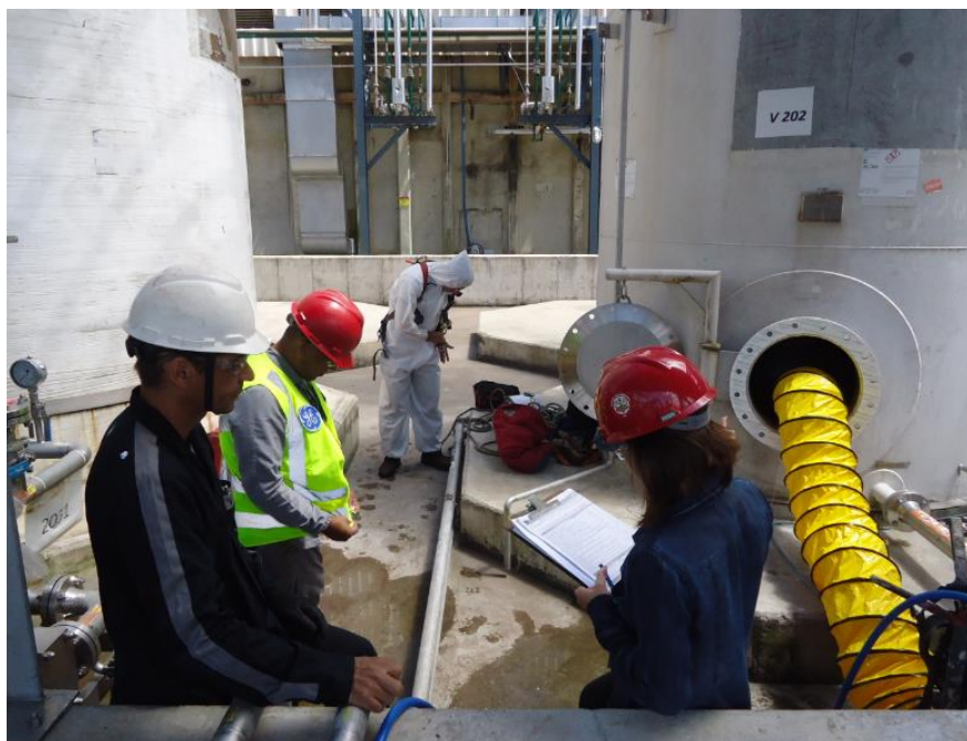
Figura 18 - Equipe envolvida no Espaço Confinado do Tanque de Ácido Fosfórico e equipamento de exaustão.
