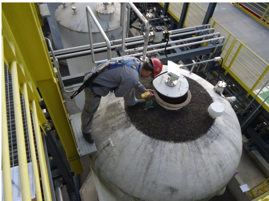
Figura 14 - Medição atmosférica no tanque de XB.
