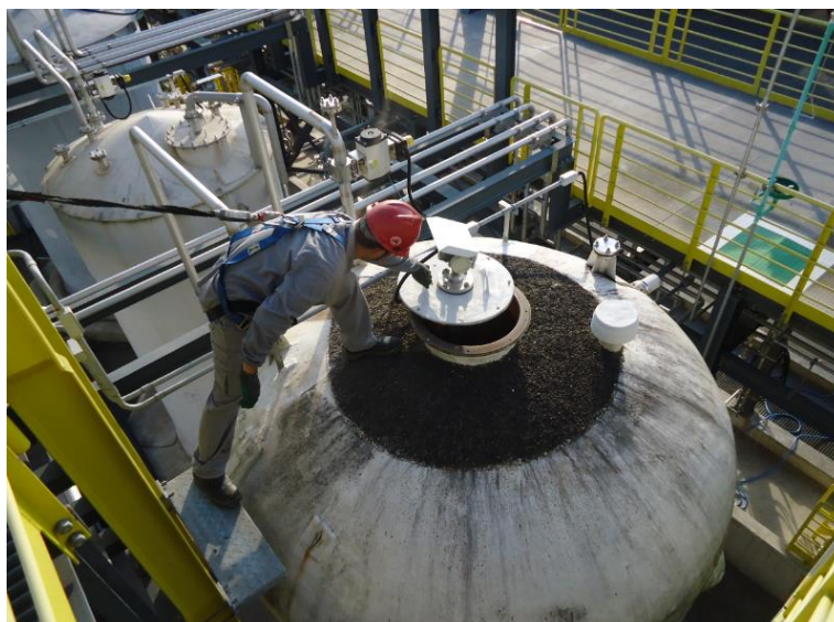
Figura 12 - Abertura da boca de visita superior do tanque de XB.
