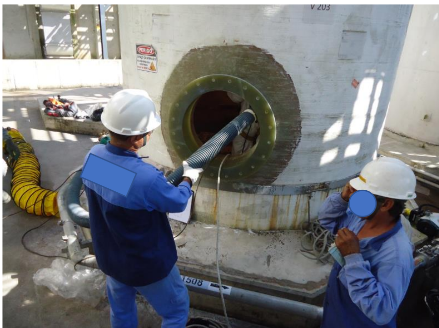
Figura 15 - Corte interno no tanque de XB com uso do Scrubber.
