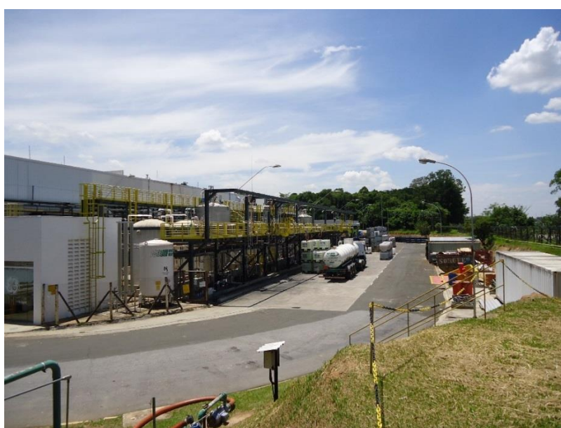
Figura 6- Imagem do Parque de Tanques
