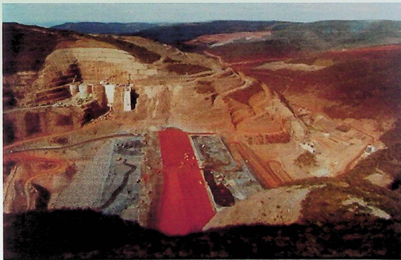
FOTO 6: Fase de construção da barragem e vertedouro de Irapé, vista da ombreira direita e do elxo da barragem – site www.irape.com.br 2004
