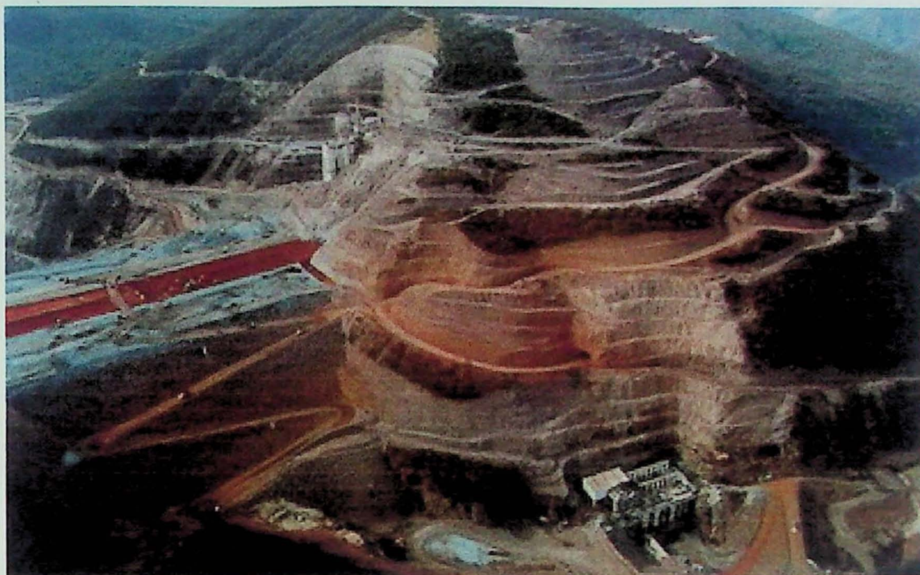
FOTO 5: Fase de construção da barragem e casa de força de Irapé, vista para ombreira esquerda. Com um plano principal para jusante do empreendimento – site www.irape.com.br 2004
