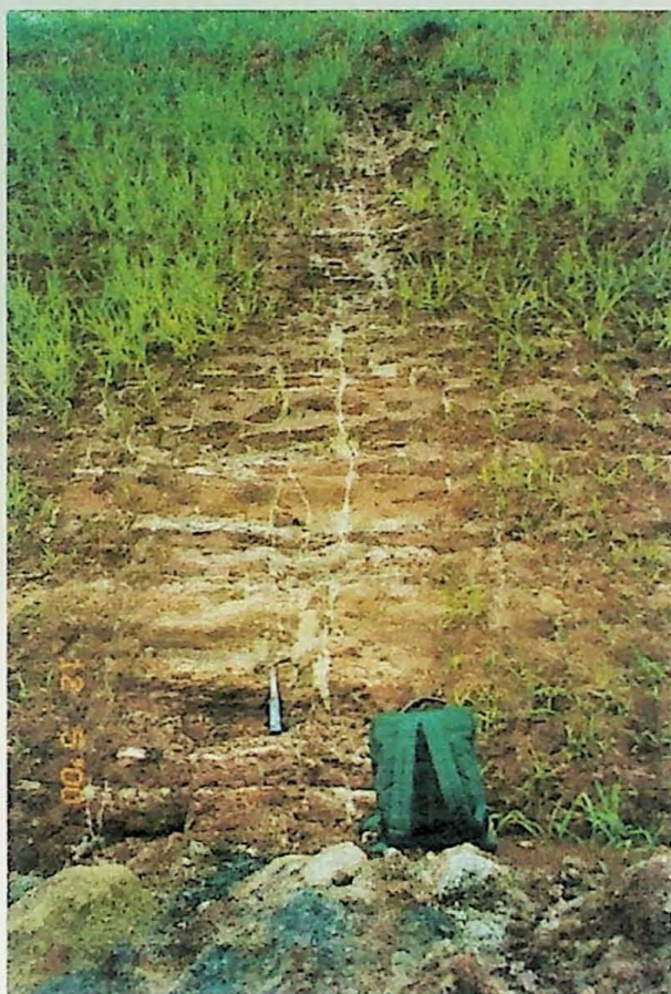
FOTO 11: Juntas verticais de atitude N30/40E cortando os siltitos vermelhos (paredes lixviadas por ação de percolação), Sadowski 2001.
