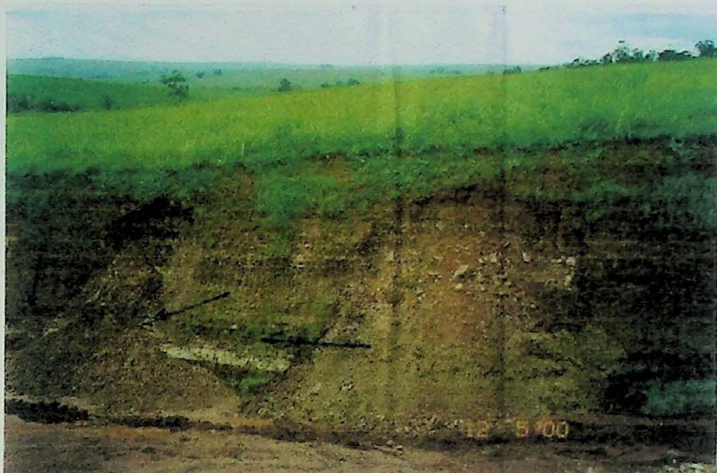
FOTO 10: Dois deslizamentos no corte da estrada. A base das fraturas, neste afloramento, localizam-se em camadas de argilitos negros com espessura decimétrica, Sadowski 2001.
