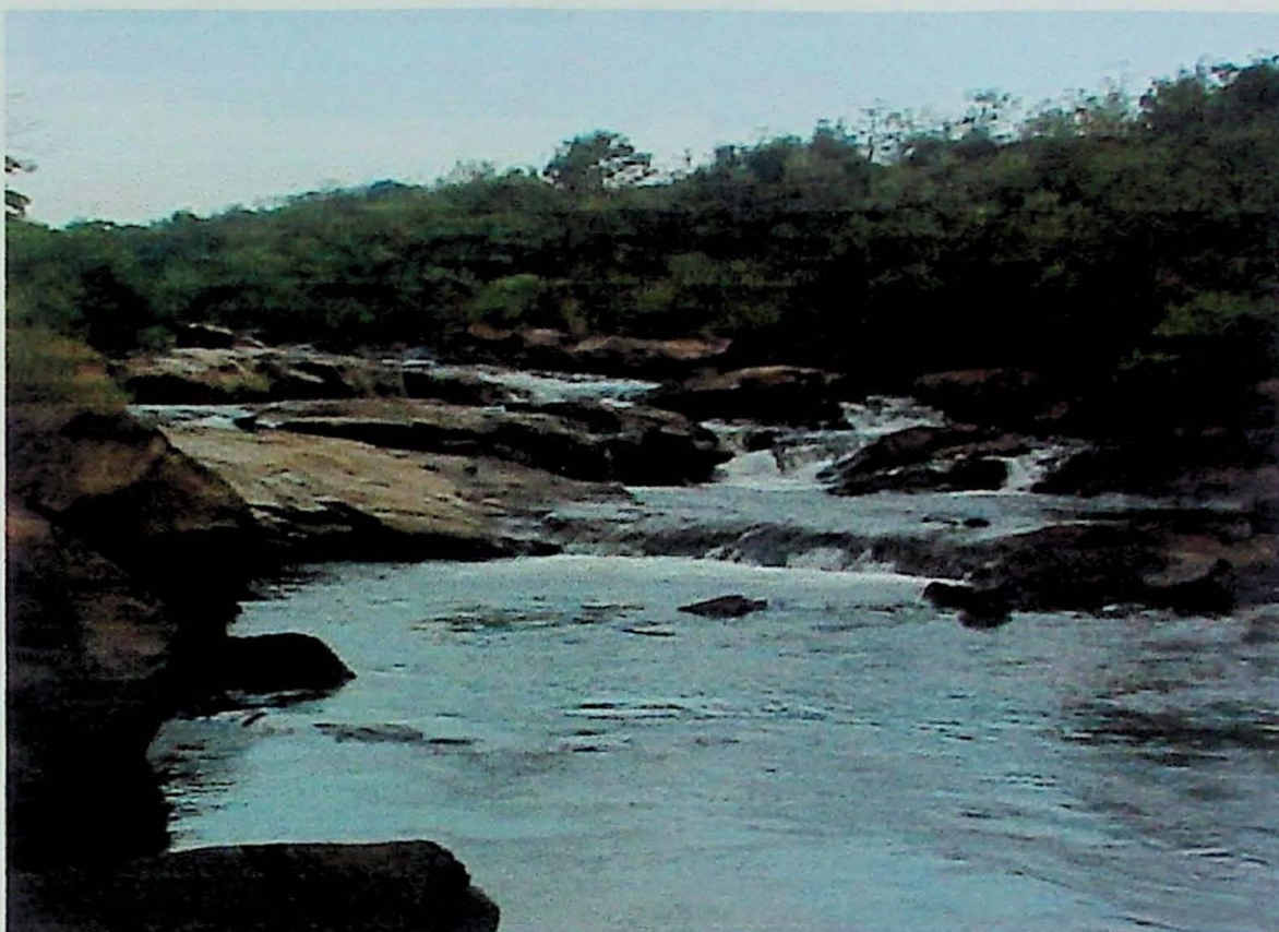
FOTO 3: Montante do eixo da Barragem vista de jusante para montante - Serra do Facão, Camargo, M. A. C. M. 2002
