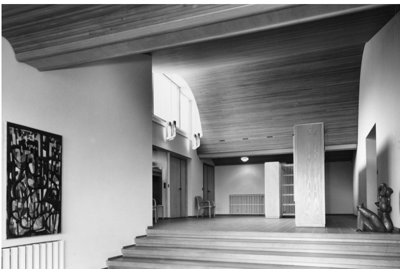
fig.19 - hall de entrada
