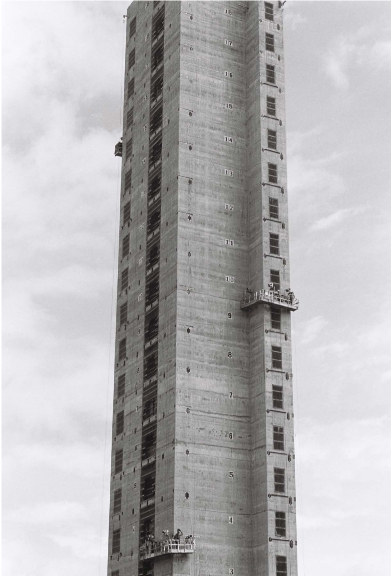
arranha-céu em construção, Londres
