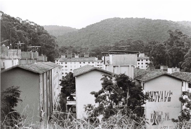
conjunto habitacional na brasilândia, são paulo
