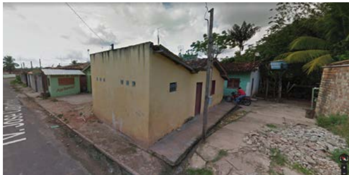
Figura 60: Diversas construções em um mesmo lote.
