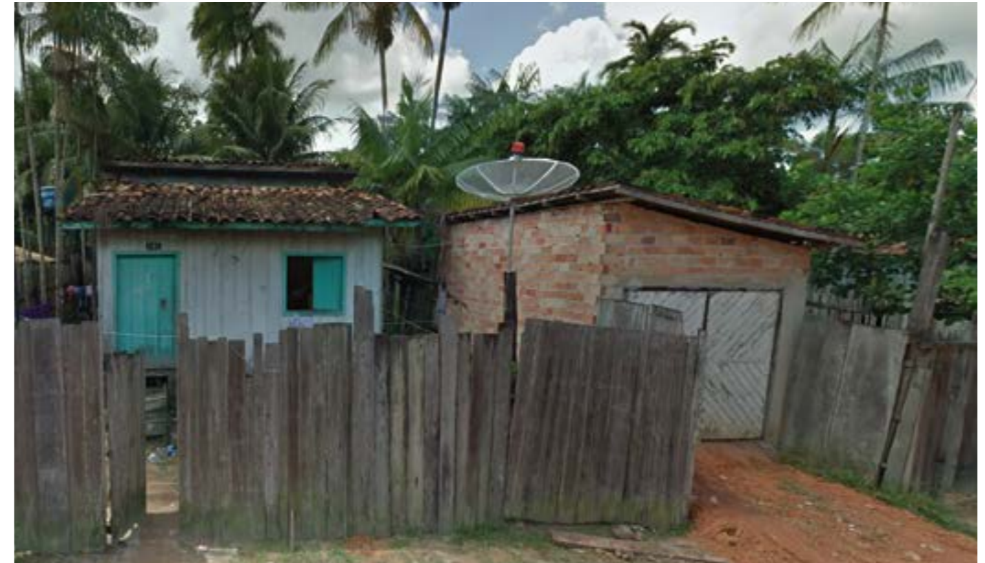
Figura 46: Casas com esquadrias feitas de madeira.
