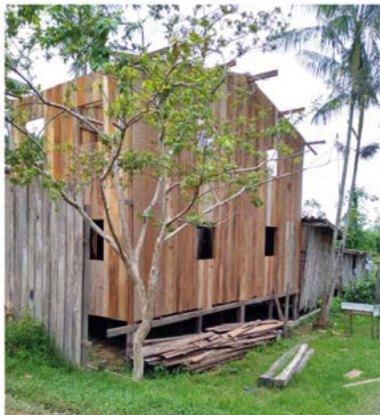
Figura 23: Construção em palafita, em andamento, localizada em área de igarapé (2020).
