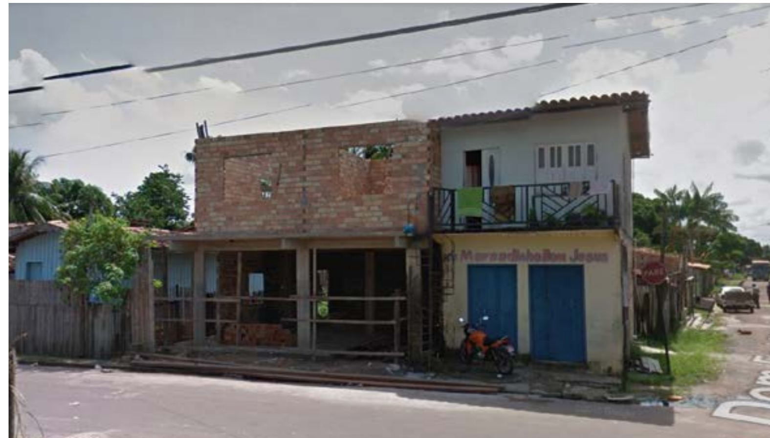
Figura 58: Construções com dois pavimentos localizadas na área abordada no Caso 1.
