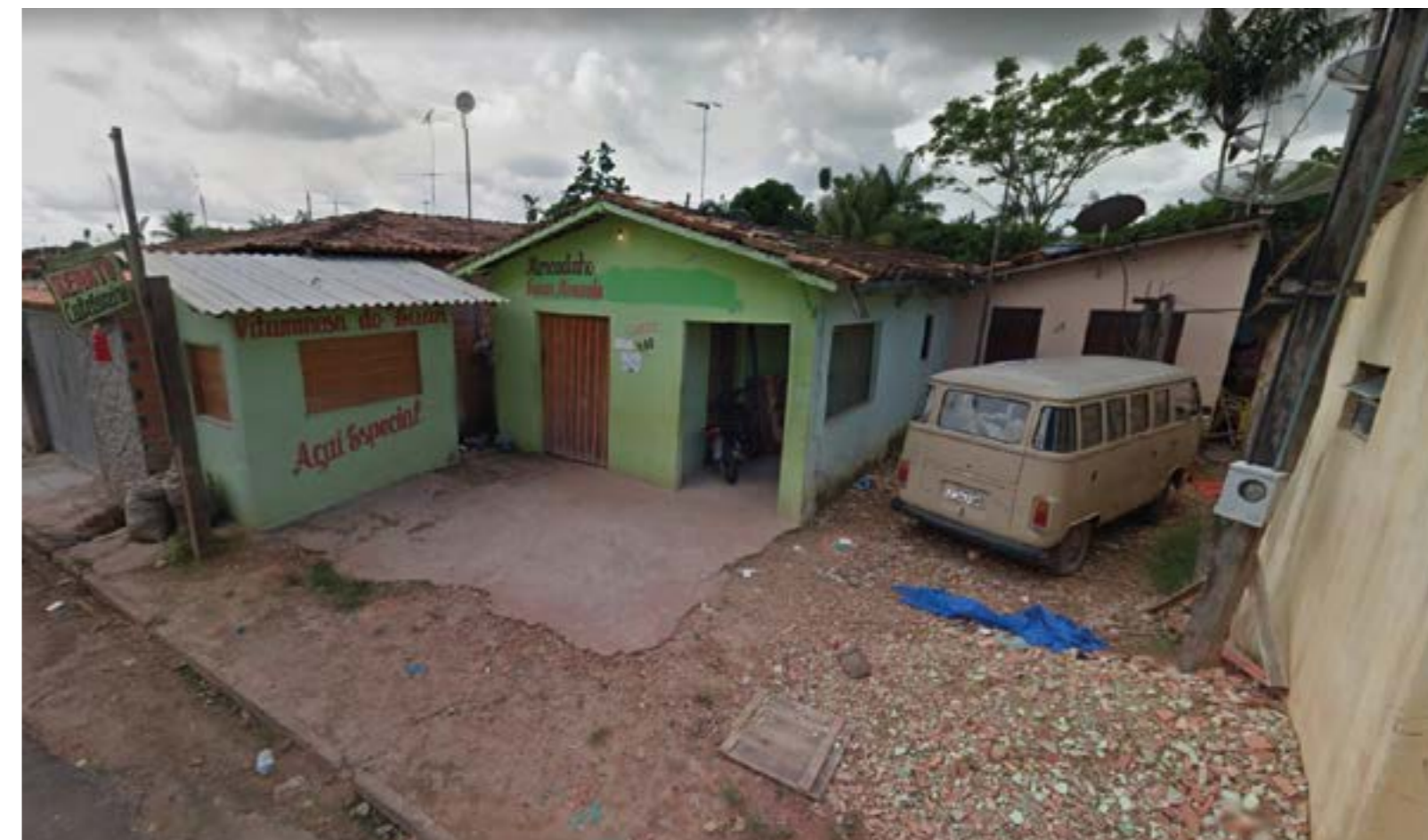
Figura 61: Diversas construções em um mesmo lote.
