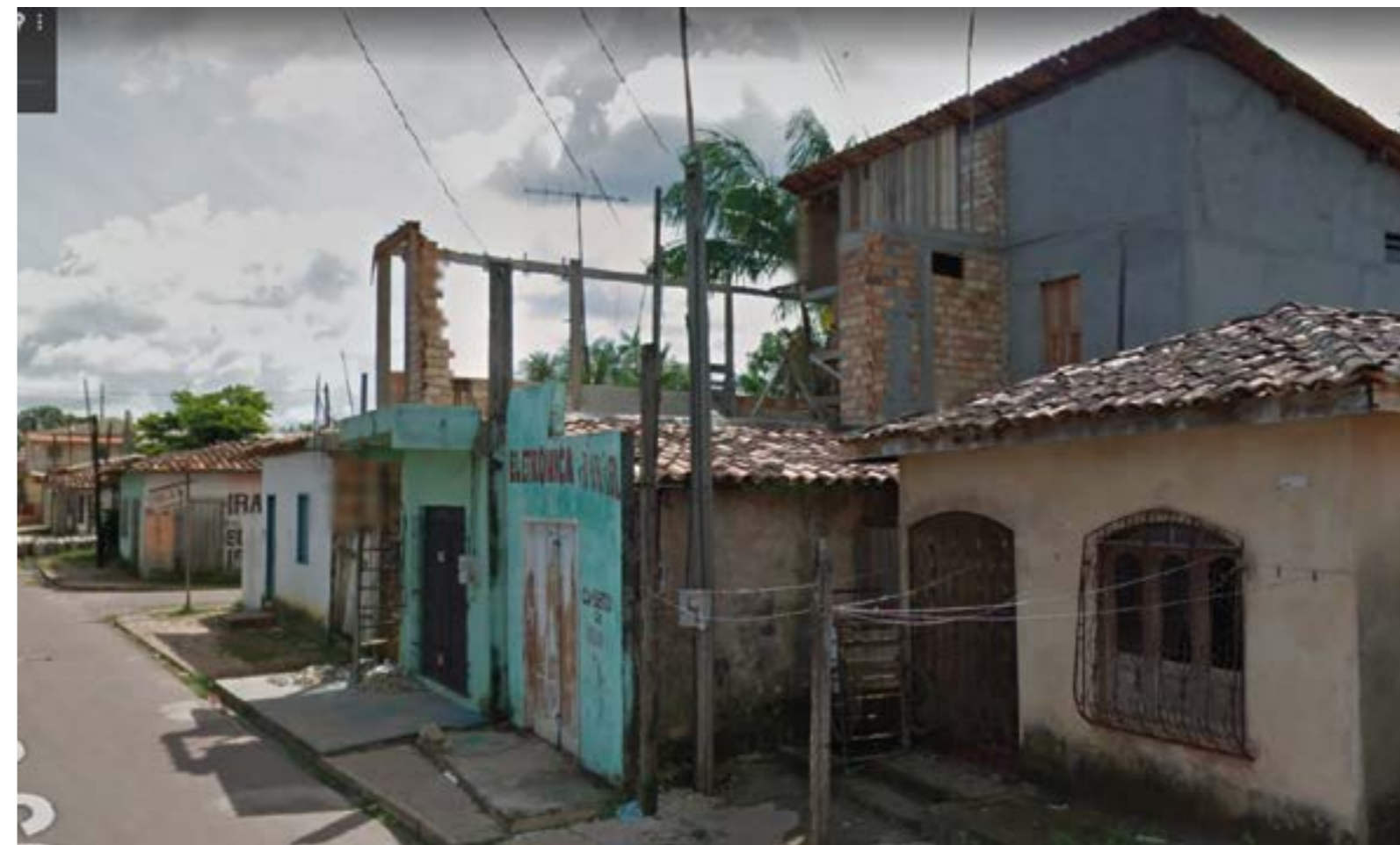
Figura 56: Obra em alvenaria. - Fiadas dos blocos executadas de maneira errônea.
