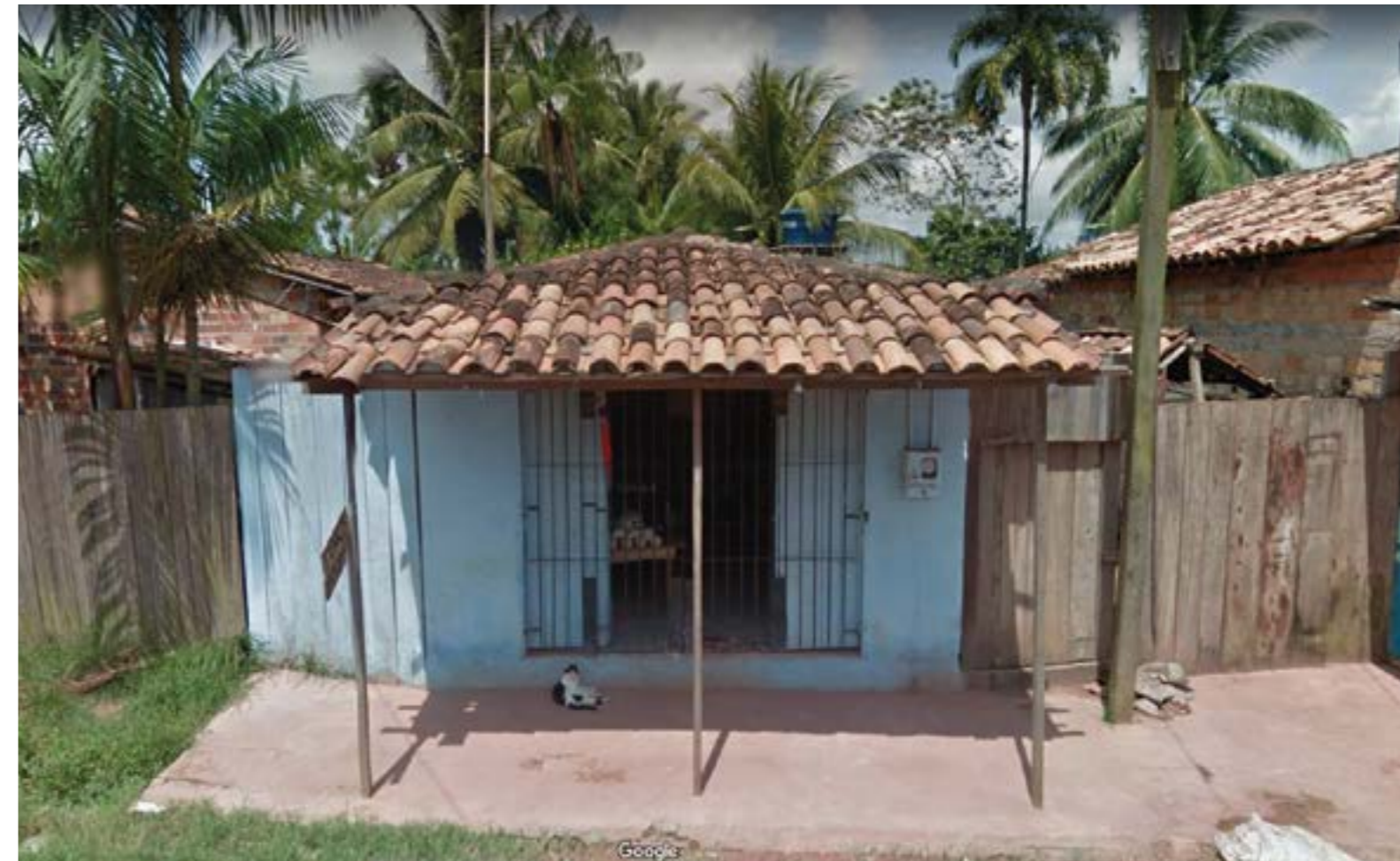
Figura 65: Construção com grades.
