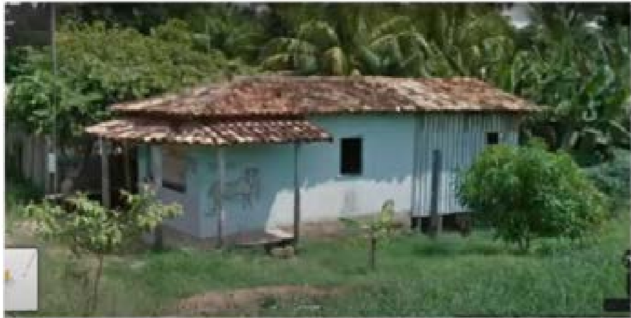
Figura 45: Construção de uso misto (açougue e residência). Junção de materiais e técnicas construtivas.
