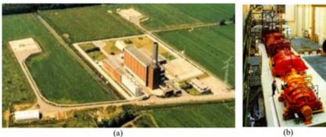
Figura 5.1: Vista aérea da usina Huntorf (a), vista do compressor e turbina (b). Fonte: Filipa Vaz Ramires Gomes da Costa (2019)
