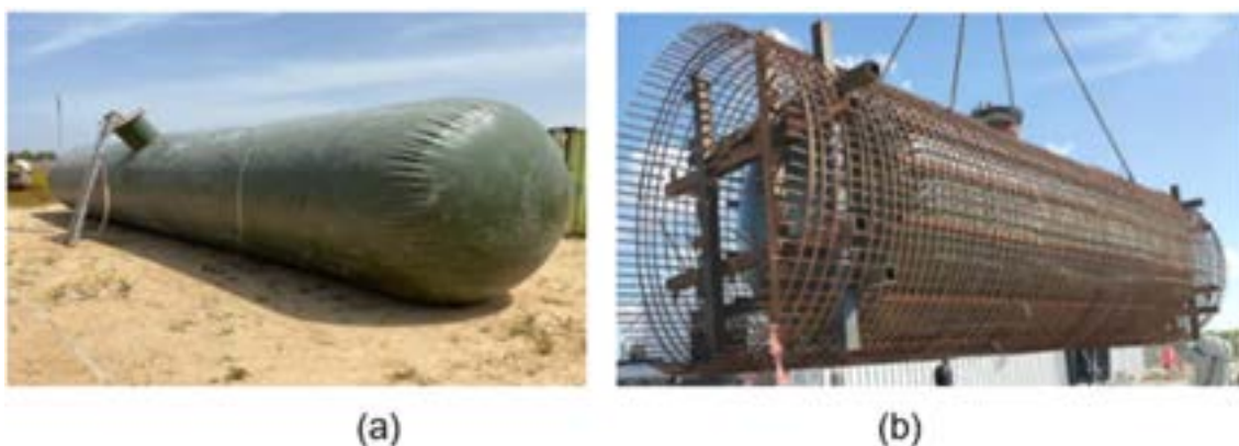
Figura 5.8: (a) vista do tanque de polímero sendo inflado. (b) Vista do tanque de polímero com a armadura de aço. Fonte: Augwind
