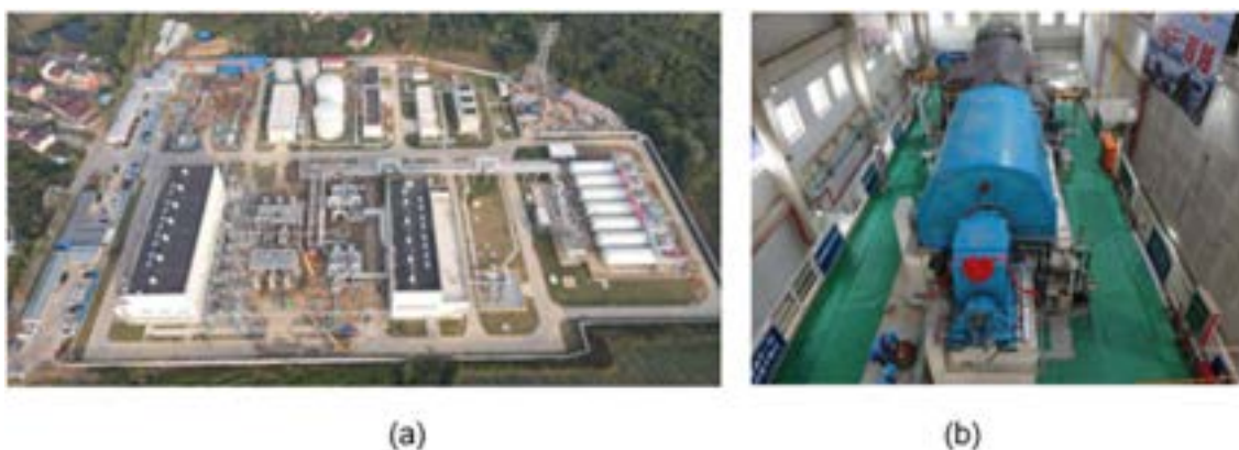
Figura 5.4: Vista aérea da usina Jintan (a), vista do compressor e turbina (b). Fonte: Tsinghua University .
