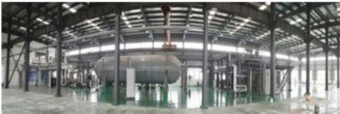
Figura 5.6: Vista do protótipo TICC - 500. Fonte: Jidai Wang (2017)
