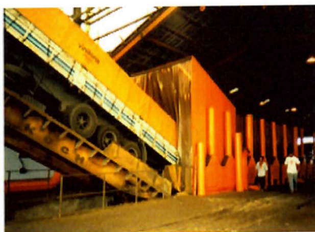
Figura 12 - Descarregamento de cereais de caminhões com moega equipada com tombador
