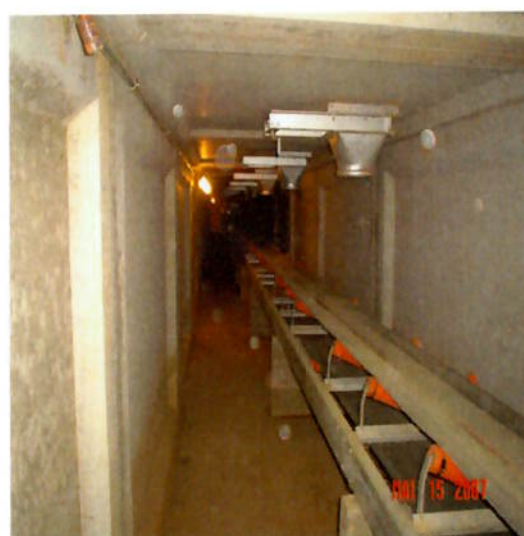
Figura 29 – Empresa que faz limpeza
