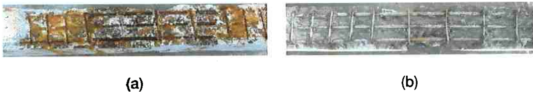
Figura 13 - corrosão em (a) concreto convencional e (b) concreto com gradação funcional (MAALEJ; AHMED; PARAMASIVAM, 2002).
